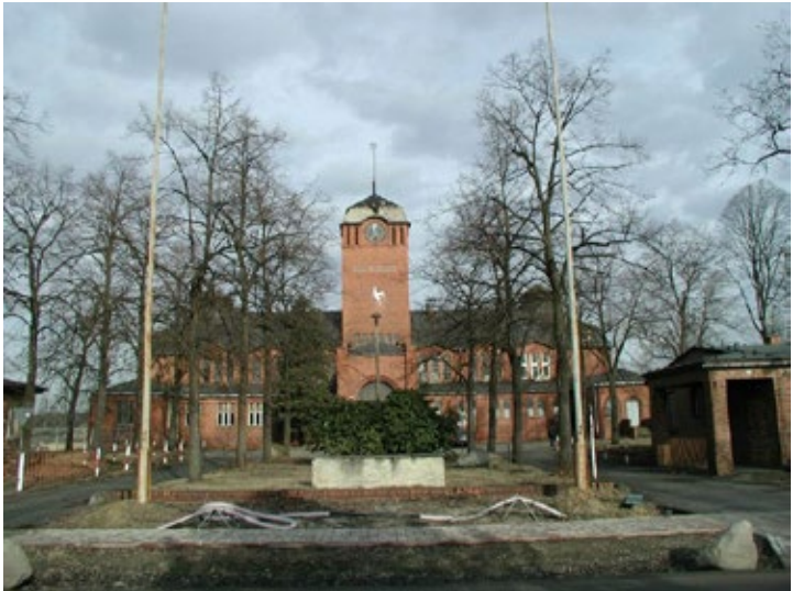
Abb. 2: Die Waschkaue von vorne. © Archiv LMBV
