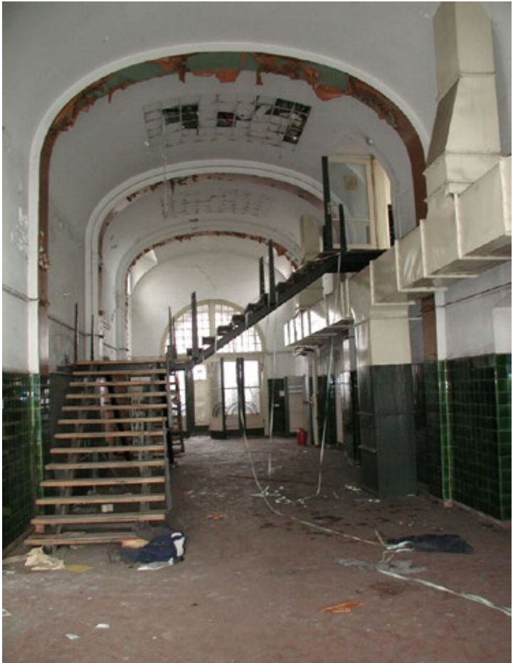
Abb. 9: Eingangshalle Waschkaue. © Archiv LMBV
